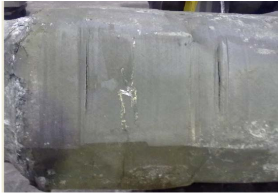
Рис. 2. Фотографія дефектної поверхні плити при протяжці плоскими бойками
